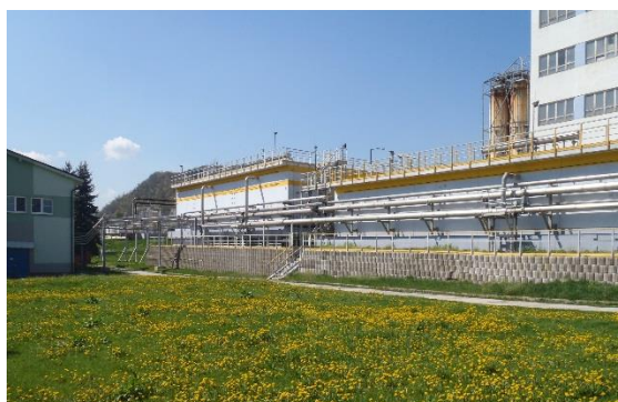
Obr. 21 Objekt ČOV a.s.
