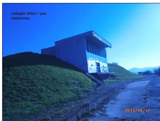
Obr. 61 Vodojem Hrby I pre nemocnicu, zdroj RÚVZ Banská Bystrica
