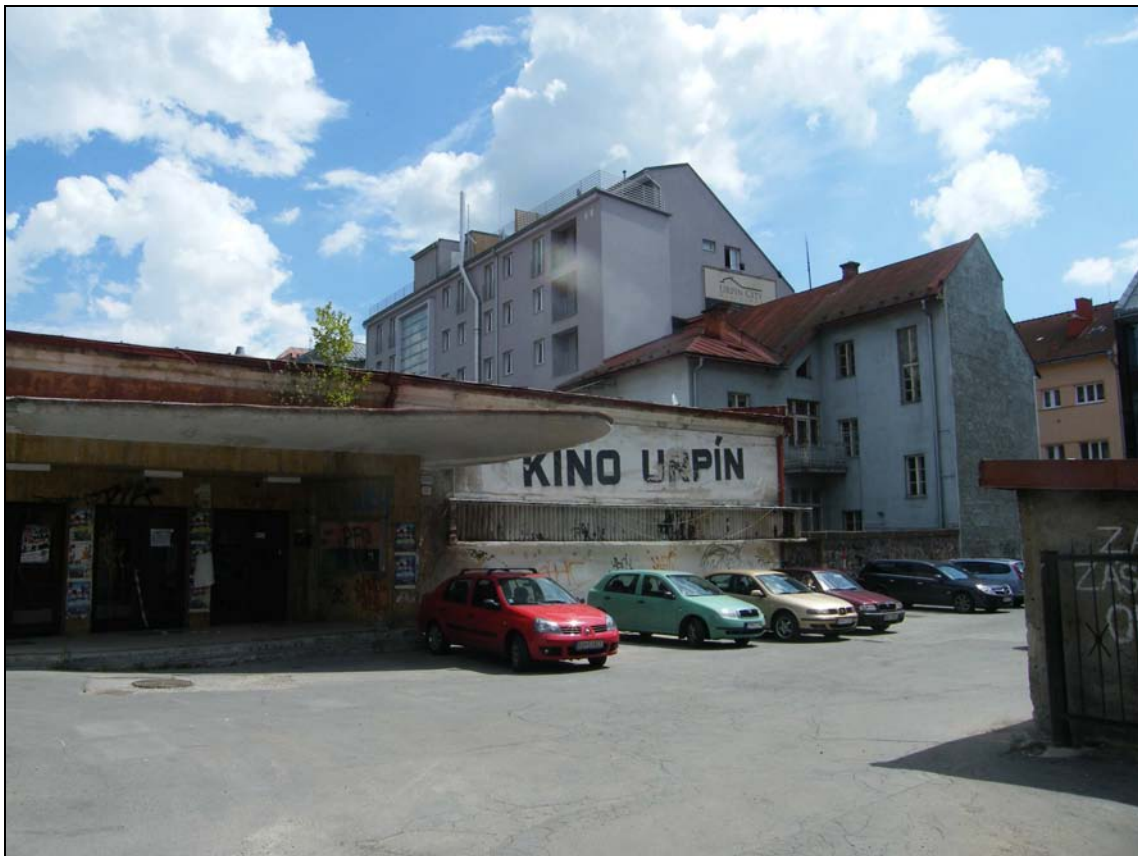
60. Pohľad do vnútrobloku, vľavo budova bývalého kina Urpín, vpravo bytový dom na Cikkerovej ulici, vzadu hotel Urpín, júl 2014.
