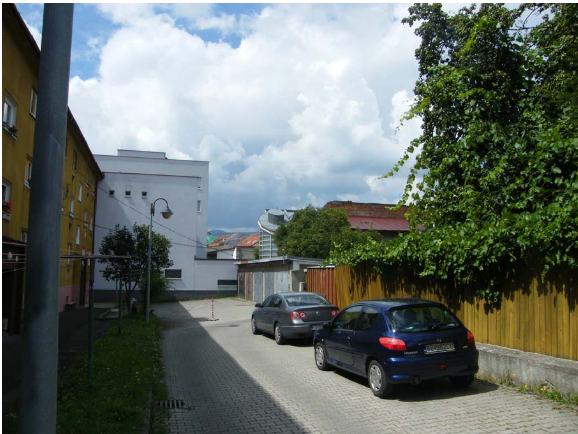
52. Pohľad do vnútrobloku medzi Dolnou a Kuzmányho ulicou, vľavo bytové domy na Kuzmányho ulici, v strede vežová stavba schodiska v závere dvorového krídla domu č. na Dolnej ulici, júl 2014.
