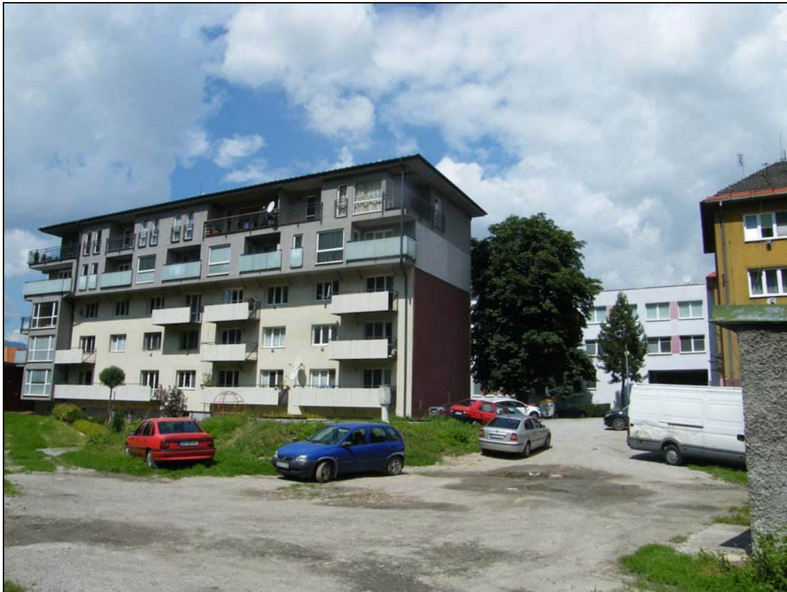
56. Pohľad do dvora za bytovými domami na juhovýchodnej strane Kuzmányho ulice, júl 2014.
