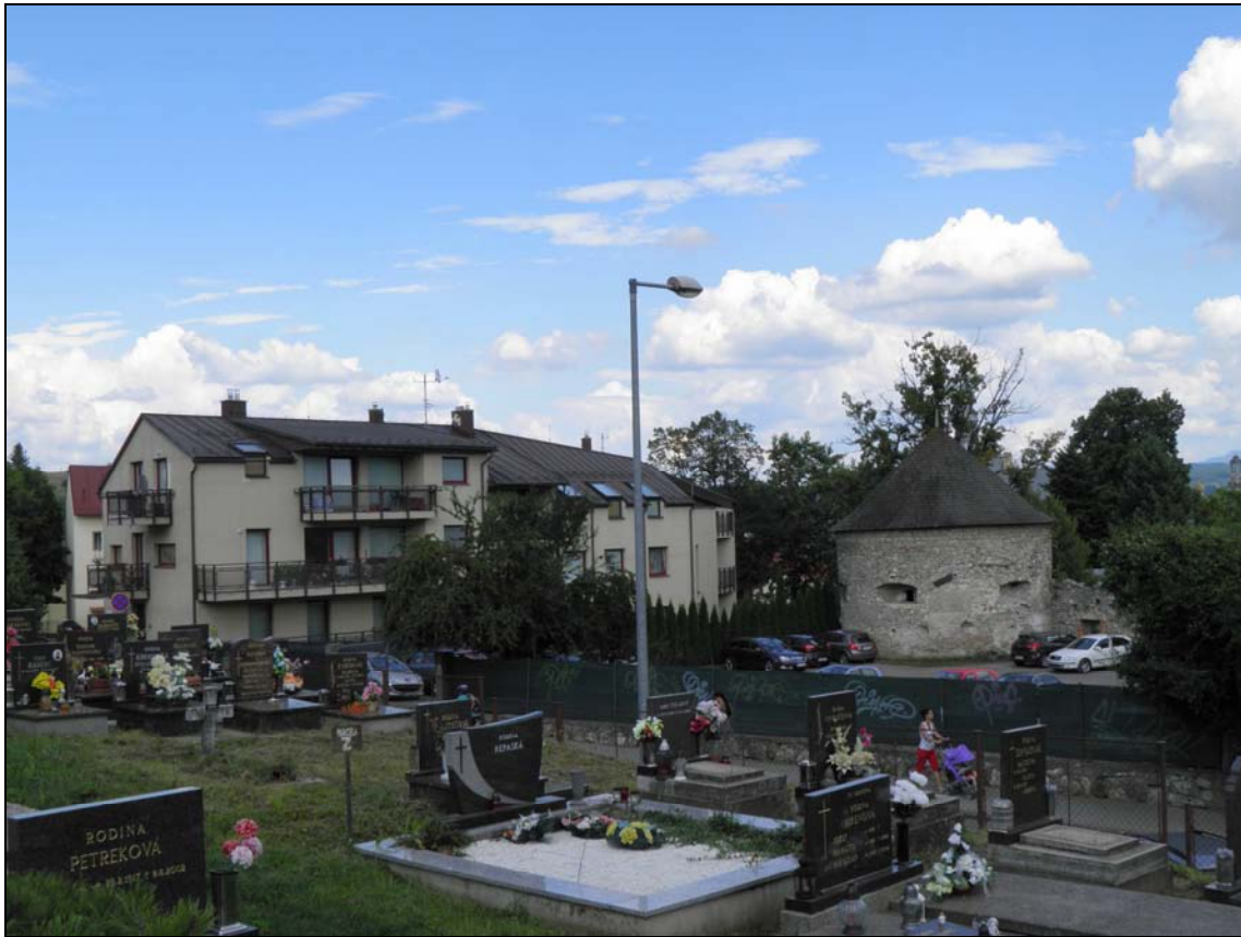
35. Pohľad z r. k. cintorína na Kollárovu ulicu, vľavo budova SKI, vpravo Šusterská bašta, júl 2014.
