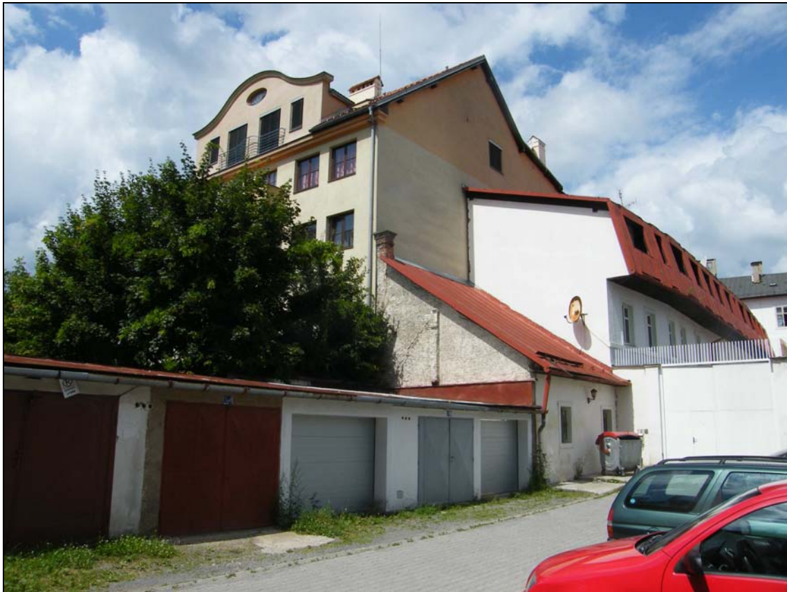
54. Pohľad do vnútrobloku medzi Dolnou a Kuzmányho ulicou, za radovou výstavbou garáží novostavba v závere dvora domu č. 19 na Dolnej ulici a juhozápadné dvorové krídlo domu č. 17, júl 2014.
