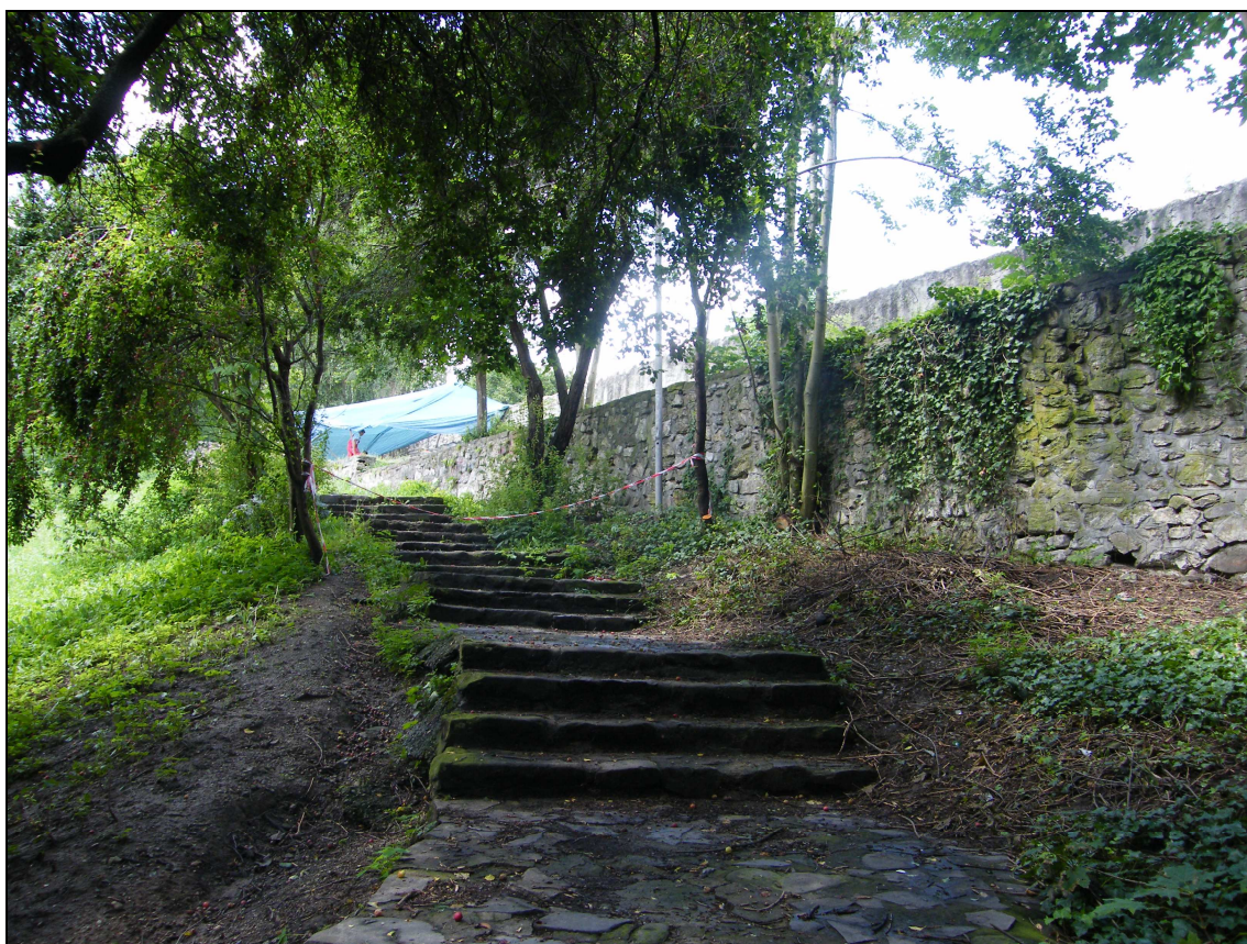
78. Juhovýchodný úsek opevnenia od Krajčírskej bašty severovýchodným smerom, júl 2014.
