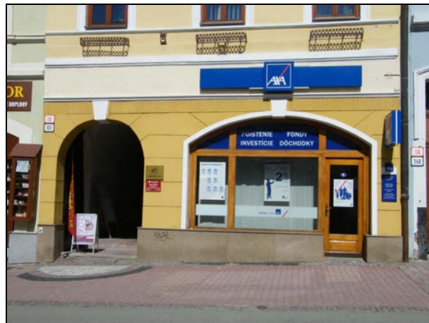
38. Dolná 18. Neprimeraná veľkosť otvoru v mieste pôvodných okien, nevhodný tvar výkladu so segmentovým záklenkom.
