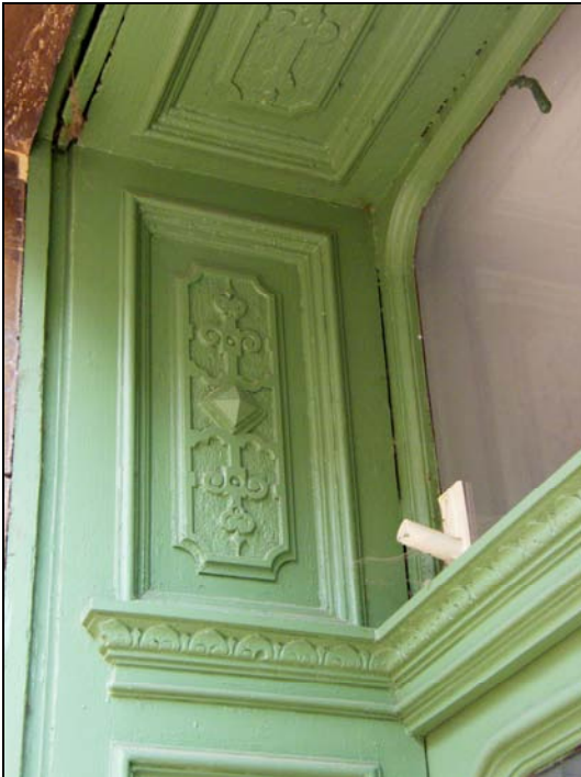
35. Dolná 7. Detail kazetovaného obkladu na ostení vstupu, koniec 19. storočia.
