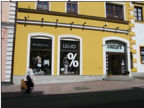
37. Dolná 10. Neprimeraná veľkosť otvorov v mieste pôvodných okien, nevhodný tvar výkladov so segmentovým záklenkom.
