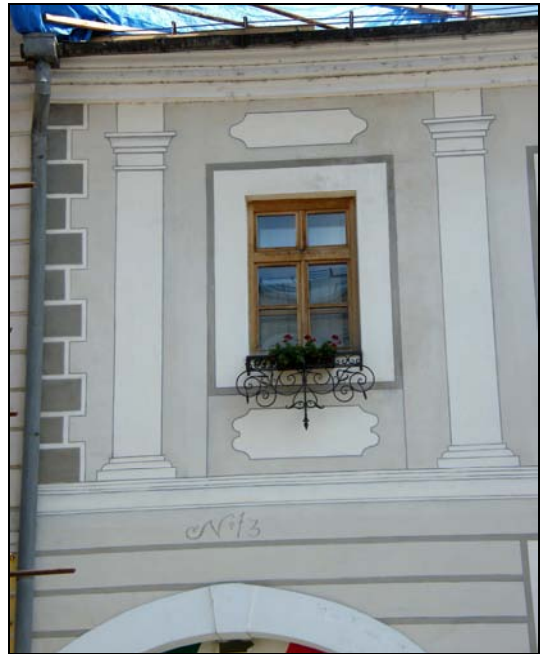
8. Dolná 1. Rekonštrukcia neskorobarokovej maľovanej výzdoby na 2.NP fasády s členením iluzívnymi pilastrami, koniec 18. storočia.
