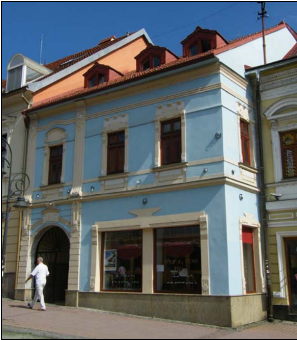
21. Dolná 21. Detail secesnej štukovej výzdoby na 2.NP hlavnej fasády, okolo roku 1915.
