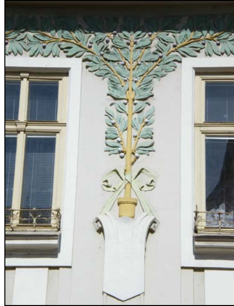
20. Dolná 30. Detail štukovej výzdoby.
