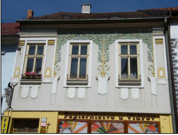
19. Dolná 30. Detail secesnej štukovej výzdoby na 2.NP hlavnej fasády, okolo roku 1915.
