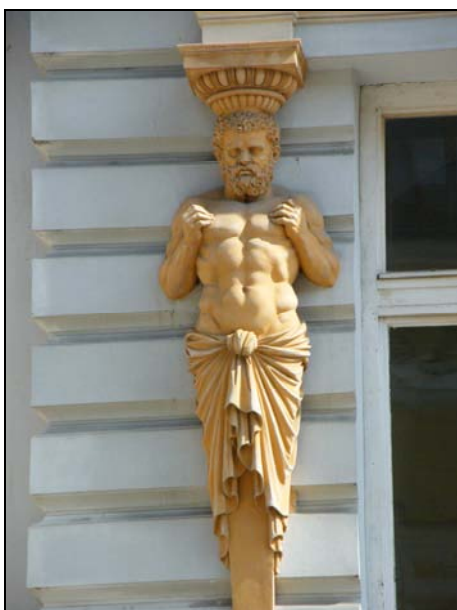
27. Dolná 13. Detail štukovej výzdoby na 2.NP hlavnej fasády, 19. storočie.
