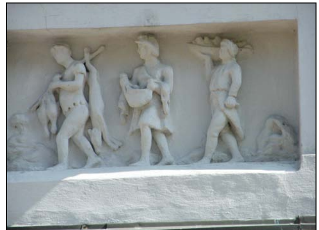
32. Podokenná výplň okna na 2.NP.
