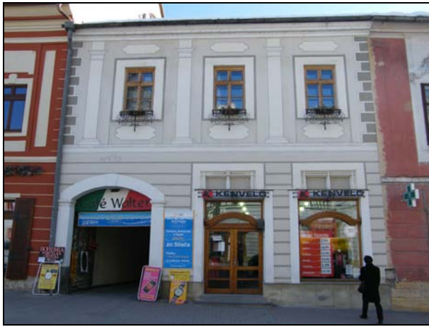
7. Dolná 1. Prezentácia neskorogotických okien na 1.NP a rekonštrukcia neskorobarokovej maľovanej výzdoby s členením iluzívnymi pilastrami, koniec 18. storočia
