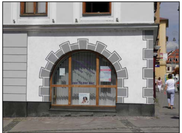
18. Námestie Štefana Moyses 11. Rekonštrukcia neskororenesančnej výzdoby na otvore podlubia.
