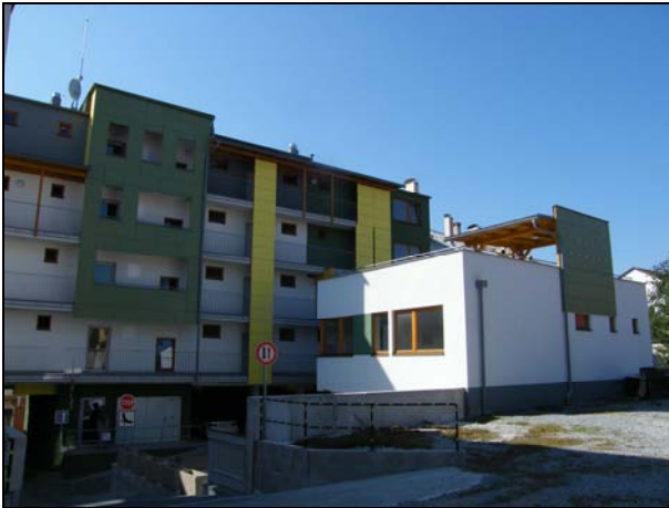
122. Horná Strieborná 15, meštiansky dom, pohľad z východnej strany z dvora domu na Námestí SNP 16. Dostavba dvorového krídla domu na Námestí SNP 14 a prieluky. Nevhodné architektonické riešenie, hmotová skladba, výškové riešenie, spôsob zástavby parcely, farebné riešenie.
