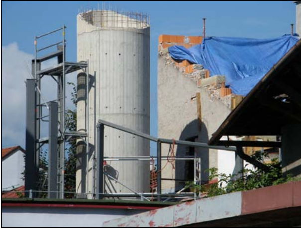
104. Dolná 15, meštiansky dom. Dostavba záveru dvorového krídla
