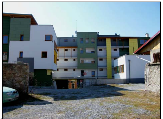
117. Horná Strieborná 15, meštiansky dom. Dostavba dvorového krídla domu na Námestí SNP 14 a prieluky. Nevhodné architektonické riešenie, hmotová skladba, výškové riešenie, spôsob zástavby parcely
