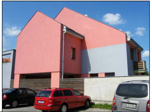
115. Dolná 15, meštiansky dom. Novostavba rodinného domu v závere parcely. Nevhodná hmotová skladba, tvar a veľkosť vikiera, farebné riešenie.
