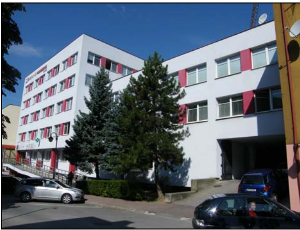
127. Kuzmányho 12, administratívna budova. Dostavba v závere parcel domov č. 35-41. Nevhodné architektonické riešenie, podlažnosť hlavnej budovy vľavo, zastrešenie rovnou strechou, farebné riešenie.
