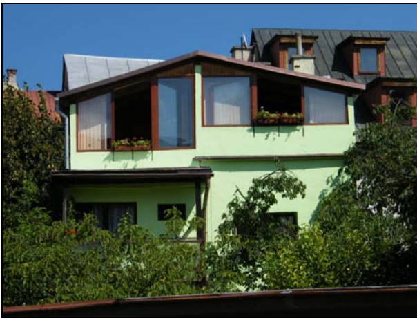
106. Horná Strieborná 11, meštiansky dom. Dostavba dvorového krídla, Nevhodný rozsah v šírke celej parcely, strecha na celú šírku parcely, celoplošné presklenie stien.
