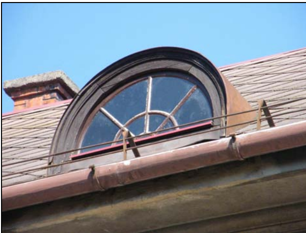
67. Kuzmányho 4, bytový dom. Bočný vikier v tvare polkužeľa oka v hlavnej osi, rok 1930.
