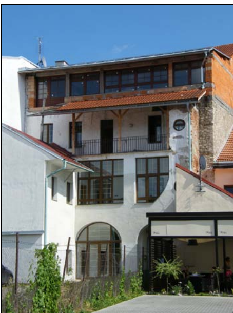
112. Dolná 15, meštiansky dom. Nevhodná nadstavba koruny uličného krídla
