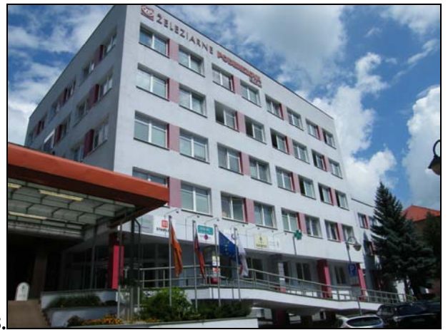
128. Kuzmányho 16, administratívna budova. Dostavba v závere parcel domov č. 43-47. Nevhodné architektonické riešenie, podlažnosť voči 2 podlažným uličným krídlam, rozsah zastavania parcely.
