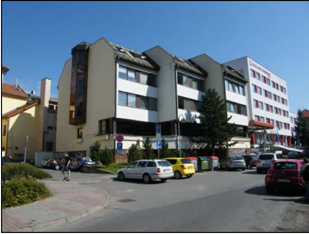
125. Kuzmányho 16, 18, administratívna budova. Dostavba v závere parcel domov č. 43-47. Nevhodné architektonické riešenie, podlažnosť voči 2 podlažným uličným krídlam, rozsah zastavania parcely.
