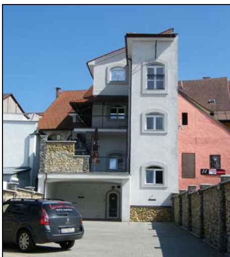
89. Dolná 26, meštiansky dom, NKP. Nadstavba sedlovej strechy na západnej strane, nadstavba úzkeho dvorového krídla, celoplošná dostavba parcely, prístavba terasy k dvorovému krídlu.
