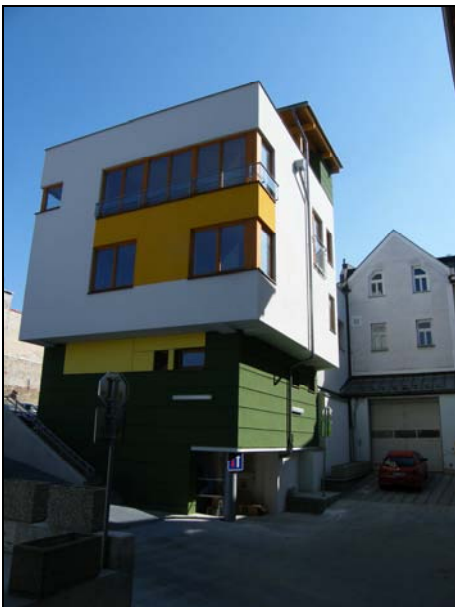
124. Horná Strieborná 15, meštiansky dom, pohľad zo severnej strany z dvora domu na Námestí SNP 16. Dostavba dvorového krídla domu na Námestí SNP 14 a prieluky. Nevhodné architektonické riešenie, hmotová skladba, výškové riešenie, spôsob zástavby parcely, farebné riešenie
