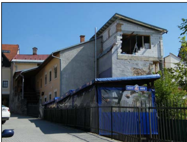
87. Dolná 22, meštiansky dom, NKP. Nadstavba dvorového krídla.
