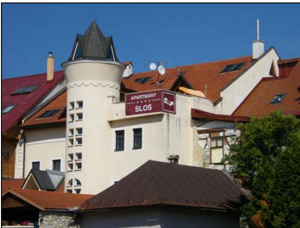
110. Horná Strieborná 15, meštiansky dom. Dostavba dvorového krídla s nevhodnou prístavbou schodiskovej veži valcovitého tvaru, neprimeranej výšky, s nevhodným zastrešením ihlanovou strechou s vikiermi.
