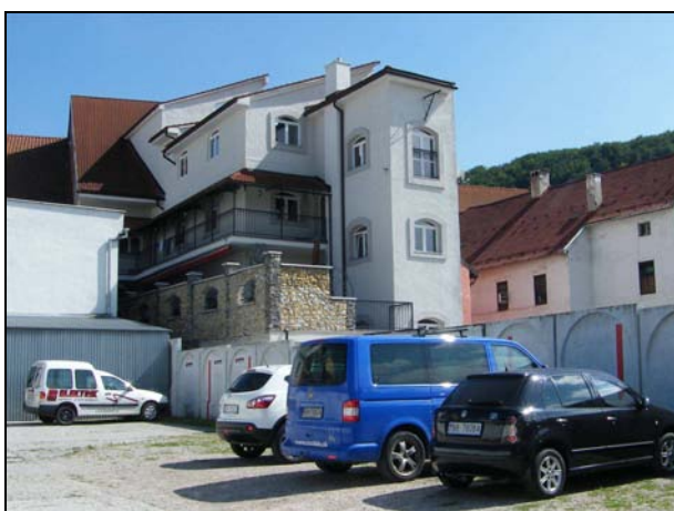
102. Dolná 26, meštiansky dom. Dostavba dvorového krídla. Neprimeraný objem a výškové riešenie voči uličnému krídlu, nevhodná hmotová skladba a nadstavba, zasahujúca do strešnej roviny uličného krídla.
