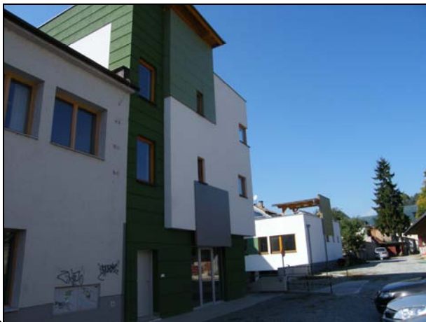
116. Horná Strieborná 15, meštiansky dom. Dostavba dvorového krídla domu na Námestí SNP 14 a prieluky. Nevhodné architektonické riešenie, hmotová skladba, výškové riešenie, spôsob zástavby parcely, farebné riešenie.
