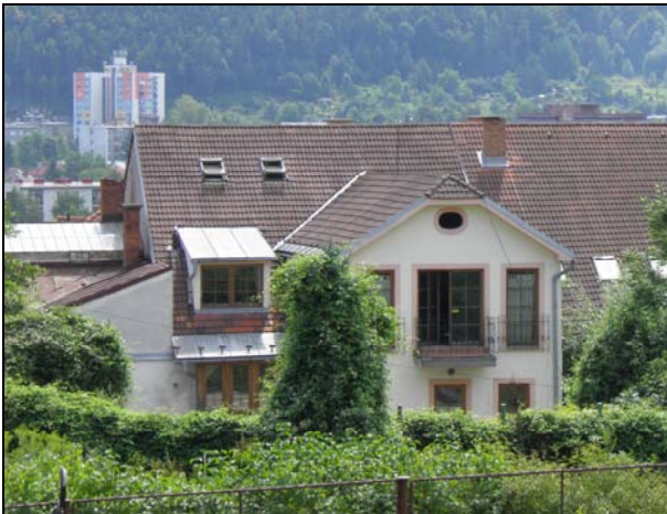
107. Horná 9, meštiansky dom, NKP. Dostavba dvorového krídla. Nevhodný rozsah v šírke celej parcely, architektonické riešenie, veľkosť a okenných otvorov.
