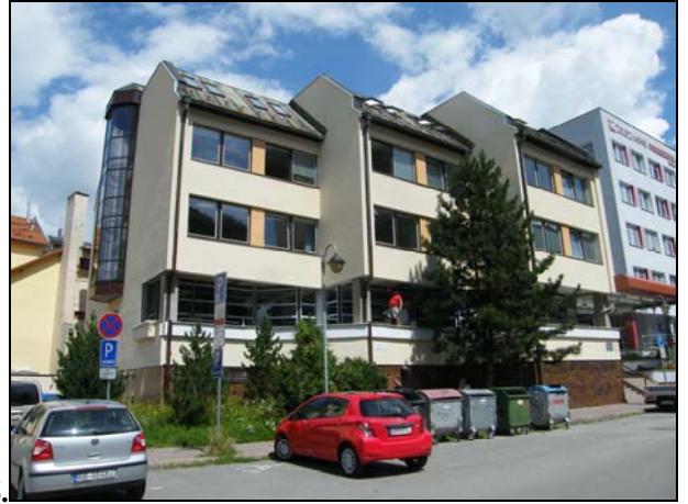
126. Kuzmányho 18, administratívna budova. Dostavba v závere parcel domov č. 35-41. Nevhodné architektonické riešenie, podlažnosť hlavnej budovy vľavo, zastrešenie rovnou strechou, farebné riešenie.
