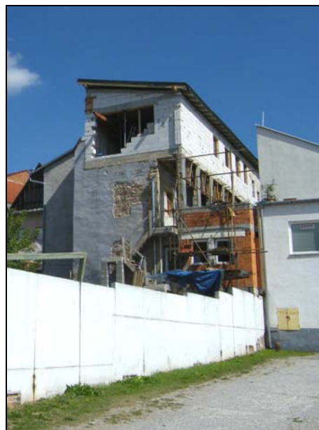
88. Dolná 22, meštiansky dom, pohľad z bočnej strany. Nadstavba dvorového krídla, predsadenie horného podlažia, celoplošná zástavba parcely.
