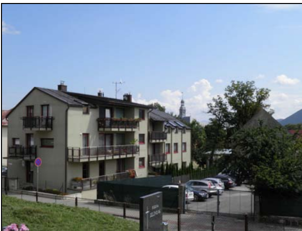
129. Kollárova 2, administratívna budova. Novostavba na predtým nezastavanej ploche pri mestských hradbách. Neprimerané hmotovo-objemové riešenie, situovanie objektu v blízkosti bašty.
