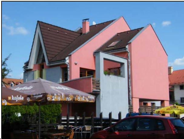
114. Dolná 15, meštiansky dom. Novostavba rodinného domu v závere parcely. Nevhodná hmotová skladba, tvar a veľkosť vikiera, farebné riešenie.
