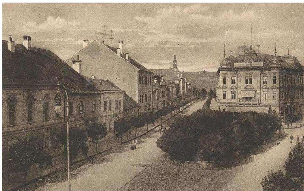
178. Horná ulica, pohľad z poschodia meštianskeho domu na juhovýchodnej strane ulice severovýchodným smerom. Vľavo meštianske domy severozápadnej radovej zástavby Hornej ulice č. 7-21, vpravo Hungaria. Dobová pohľadnica, okolo roku 1910. Zdroj: www.profil.hu .
