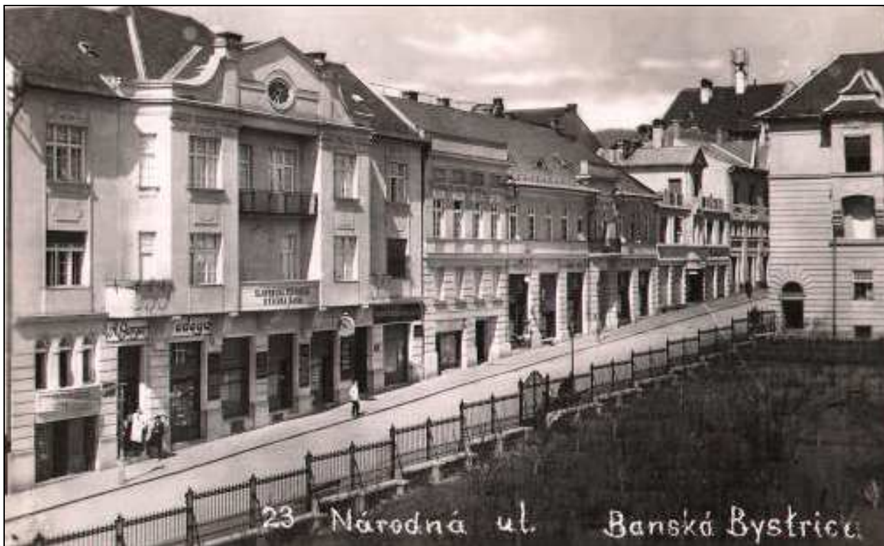
191. Národná ulica, pohľad na novú radovú zástavbu západnej strany ulice. Dobová pohľadnica, koniec 30. rokov 20. storočia.
