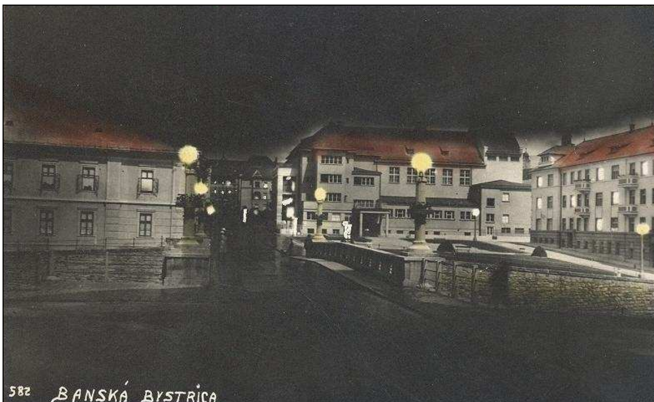
196. 582 BANSKÁ BYSTRICA Národná ulica, pohľad z ľavého brehu Hrona. Vľavo hospodárska budova bývalého Kammerhofu, v strede Národný dom, vpravo bytový dom (Národná 13, 15). Dobová pohľadnica, 30. roky 20. storočia. Zdroj: www.profila.hu .
