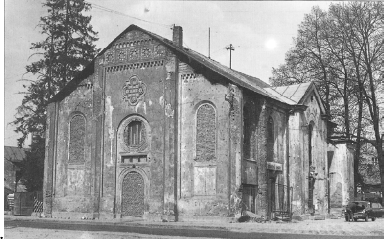
246. Neologická židovská synagóga na ulici Janka Kráľa po stavebných úpravách (zníženie koruny muriva, nová strechy, zamurovanie otvorov), rok 1974, asanovaná v roku 1981. Reprodukcia z knihy Baláž: Banská Bystrica v premenách času 2004, s. 171, obr. 244a.
