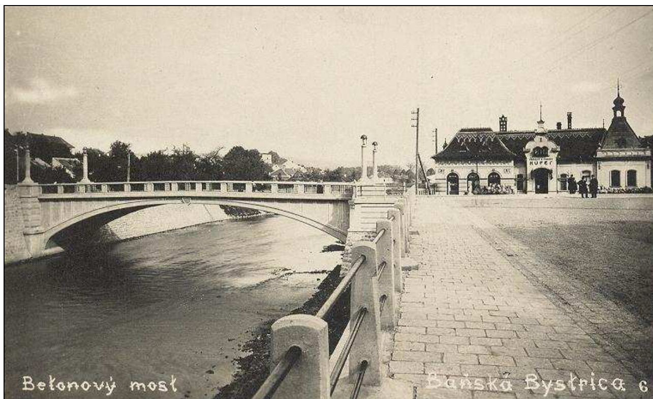
259. Vľavo železobetónový most z Národnej ulice k malej železničnej stanici, postavený podľa projektu architekta Emila Belluša, zničený pri ústupe nemeckých vojsk, vpravo Nádejovské kúpele na ostrove medzi ramenami Hrona. Dobová pohľadnica, 30. roky 20. storočia. Zdroj: www.profila.hu .
