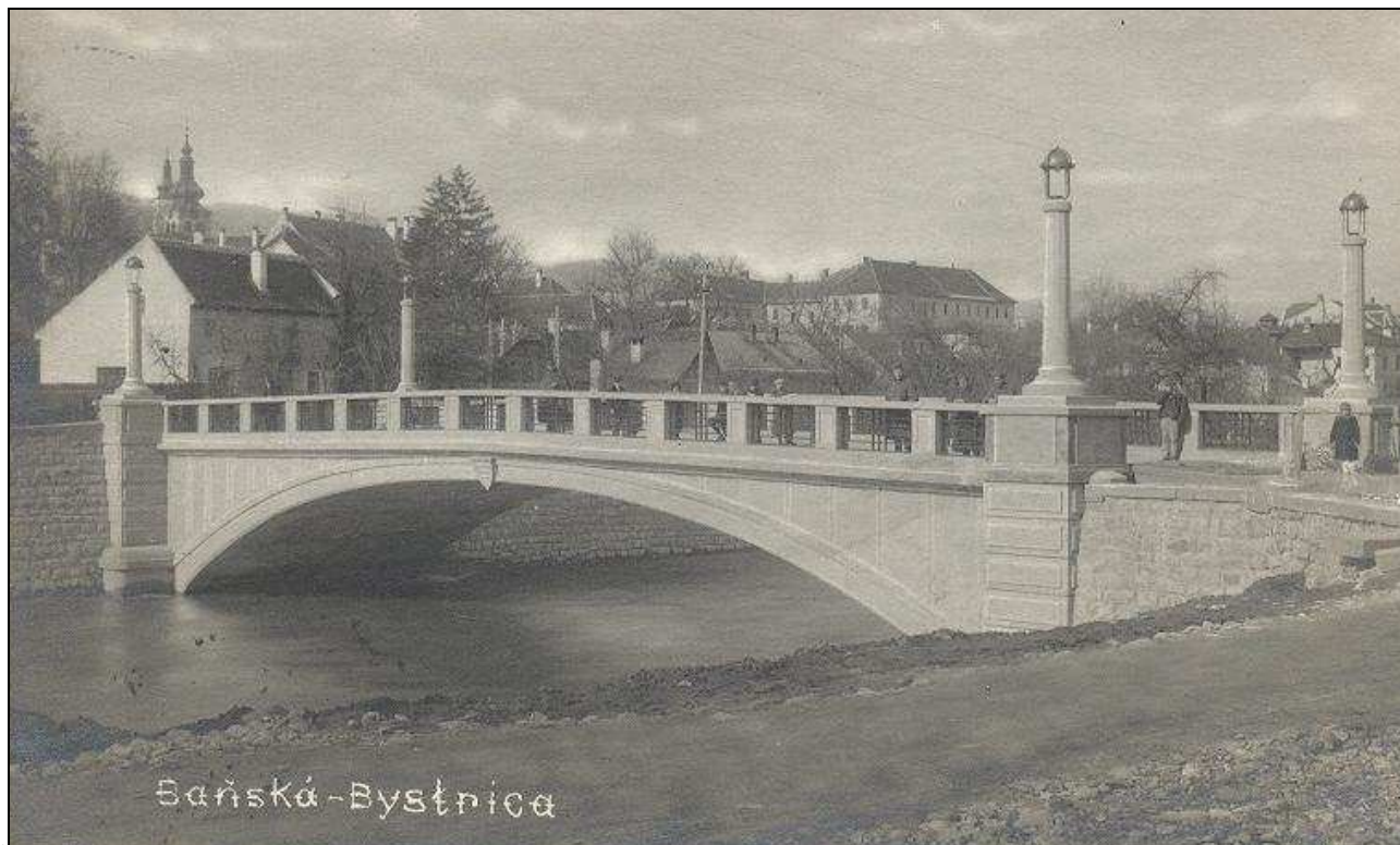
258. Železobetónový most z Národnej ulice k malej železničnej stanici, postavený podľa projektu architekta Emila Belluša, zničený pri ústupe nemeckých vojsk. Dobová pohľadnica, 30. roky 20. storočia. Zdroj: www.profila.hu .
